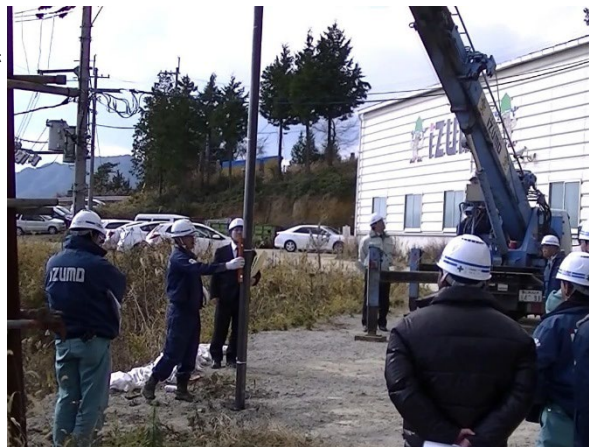
施工後確認状況
