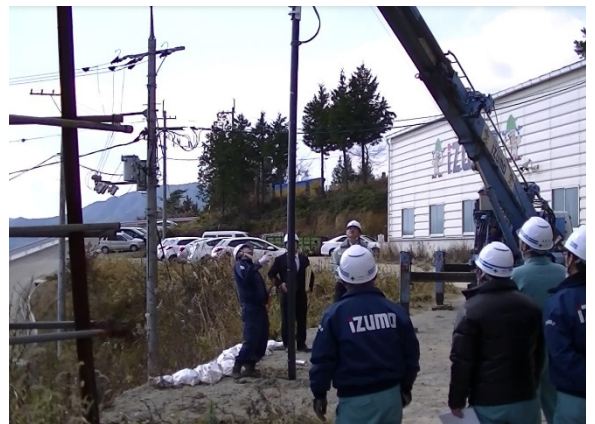
施工後確認状況
